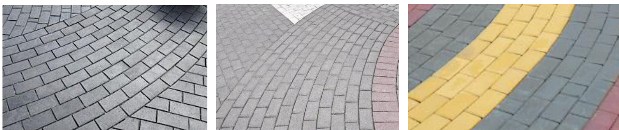
Рисунок 3. Мощение по кругу тротуарной плиткой «Кирпичик»
