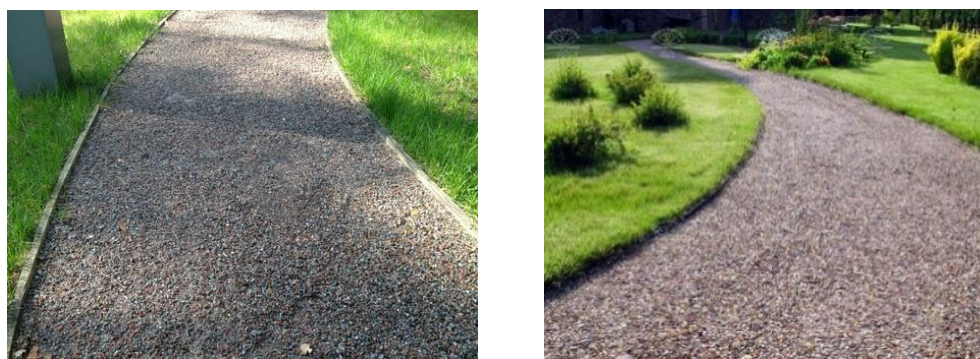
Рисунок 7. Набивные дорожки из гранитного щебня
