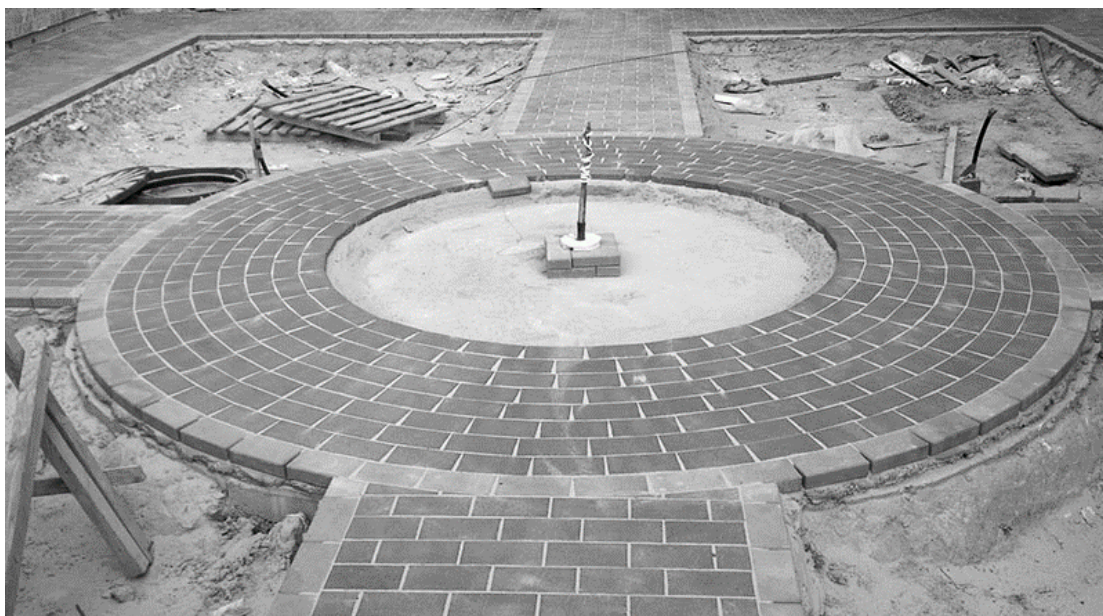
Рисунок 5. Круговая укладка тротуарной плитки «Кирпичик»
