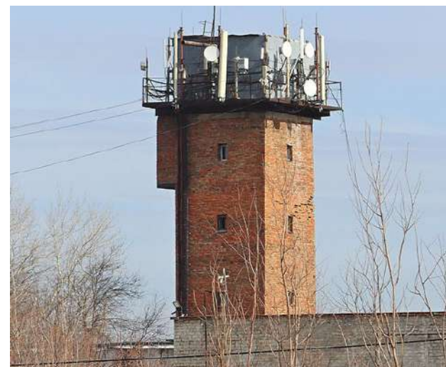
Водонапорная башня на Утевской улице, г. Самара
