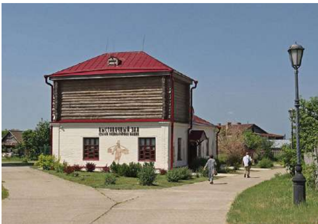
Выставочный зал «Старая водонапорная башня», г. Свияжск
