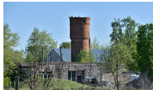
Водонапорная башня, г. Красный Холм
