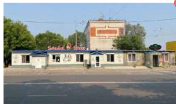
Отсутствует единый СТИЛИСТИЧЕСКИЙ ПРИЕМ отделки фасада
