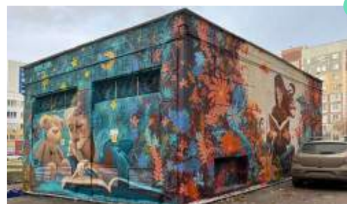
Трансформаторная подстанция, г. Набережные челны
