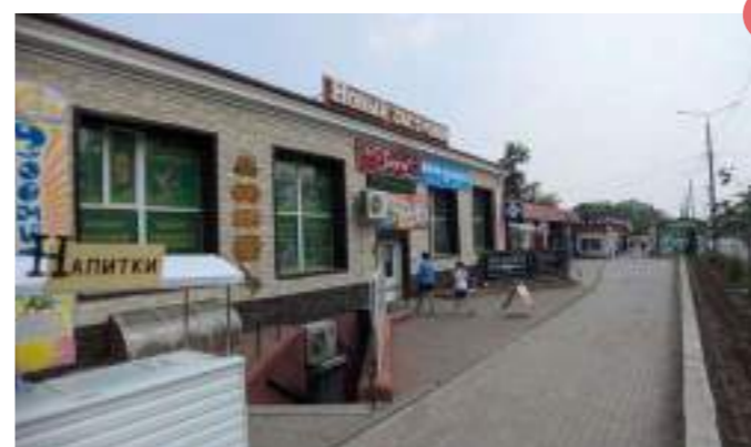
Избыточное количество РЕКЛАМНЫХ КОНСТРУКЦИЙ И ВЫВЕСОК перегружают фасад
