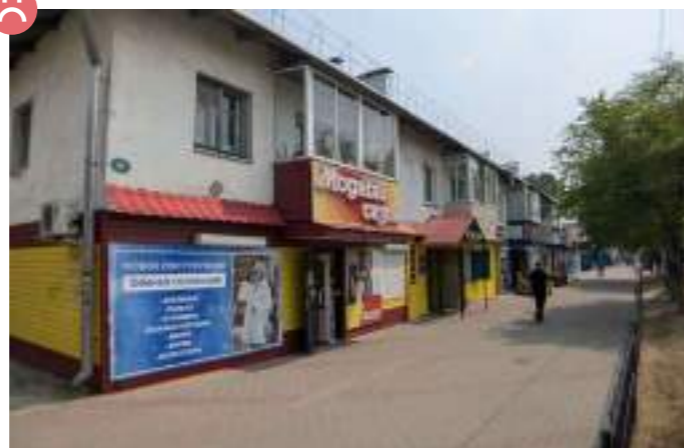
На тротуаре отсутствует освещение. В вечернее время место ощущается небезопасным
