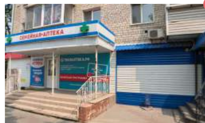
ЗАМУРОВЫВАНИЕ существующих оконных проемов нарушает первоначальный облик
