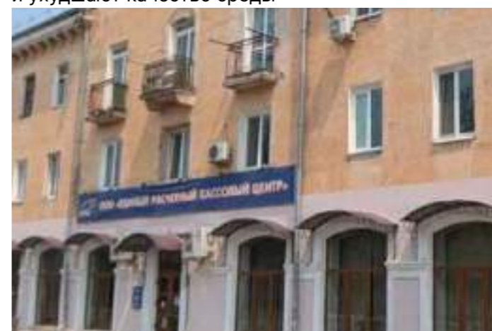
РАЗМЕЩЕНИЕ КОНДИЦИОНЕРОВ и других инженерных коммуникаций нарушает целостность фасада
