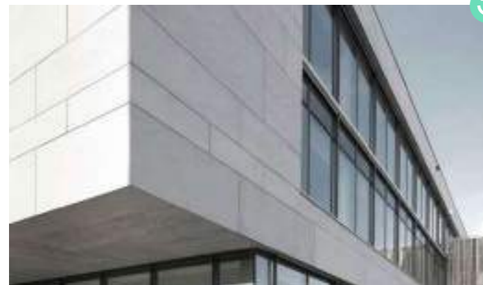
СКРЫТОЕ КРЕПЛЕНИЕ позволяет избежать видимых элементов крепежа на поверхности фасада, обеспечивая более чистый и цельный архитектурный облик здания
