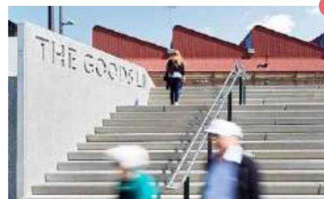
Несмотря на то, что лестница оснащена разделительными двусторонними поручнями, на ней отсутствует ограждение с другой стороны
