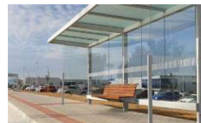
Автобусный павильон оборудован скамейкой и пространством для размещения коляски. Край платформы оборудован тактильными плитками
