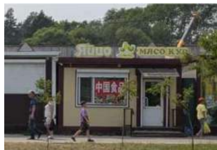
Вывески находятся в плохом состоянии (выцветшие цвета, сломанные и подверженные коррозии конструкции).
