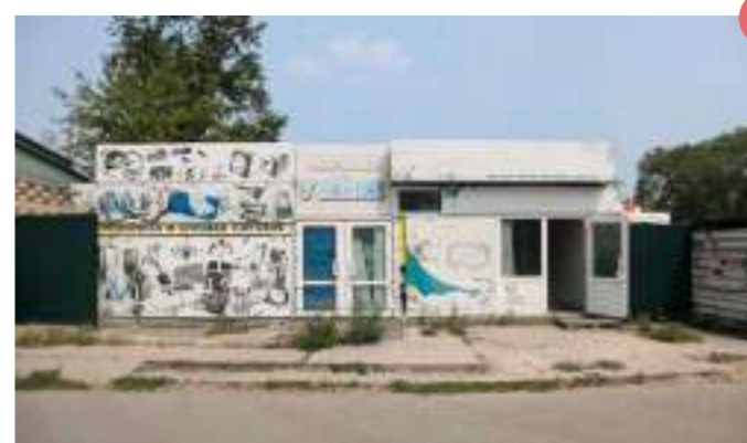
ВЕТХОЕ СОСТОЯНИЕ отделки фасада, требующее ремонта, создает безжизненный, отталкивающий вид
