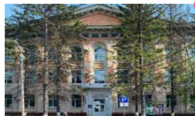
ОТДЕЛКА ФАСАДА требует проведения ремонтных работ
