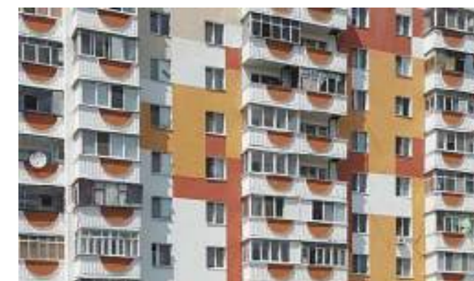
Применены ЕДИНЫЕ РЕШЕНИЯ для балконов при капитальном ремонте фасада
