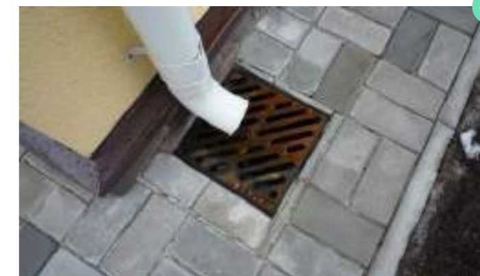
ВОДОСТОЧНАЯ ТРУБА обеспечивает отвод воды от стены здания благодаря интегрированному в мощение дождеприемнику
