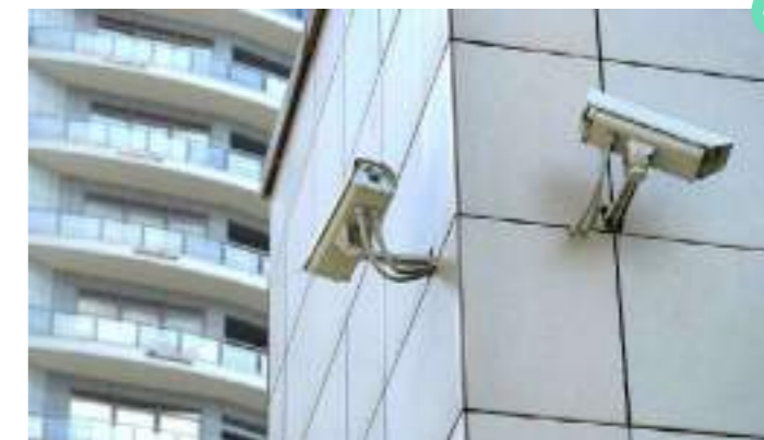
ВИДЕОКАМЕРА размещена на свободном от декоративных элементов участке фасада и выполнена со скрытой прокладкой всех необходимых коммуникаций
