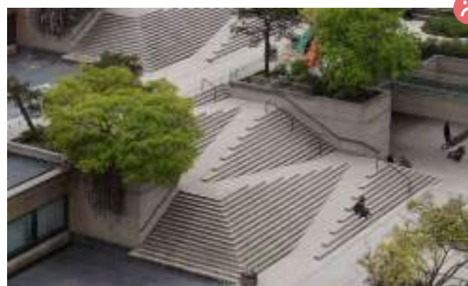
Уклон стрампа превышает 5-8%, что предоставляет собой опасность для маломобильных граждан
