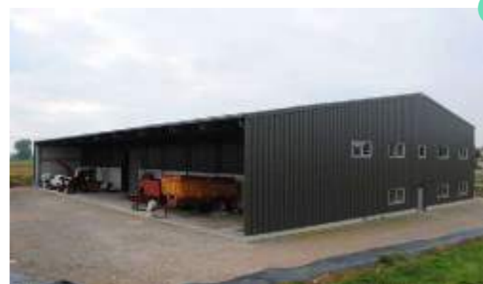
Склад спецтехники, г. Москва
