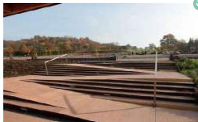
Страмп выполнен с нормативным уклоном для безопасности маломобильных граждан
