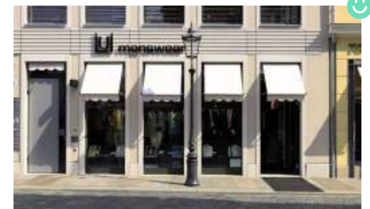
Установленные маркизы соответствуют ГАБАРИТНЫМ ТРЕБОВАНИЯМ
