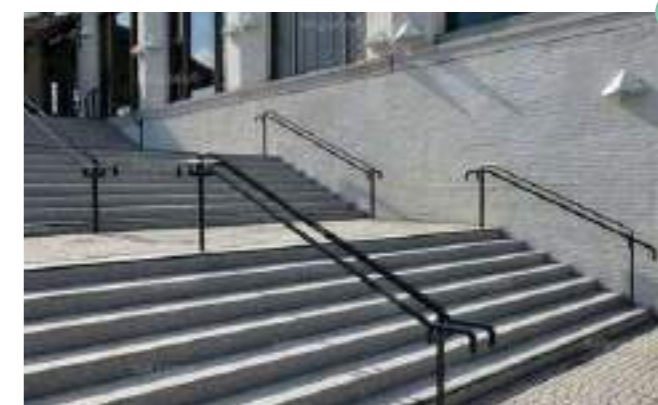
Широкая лестница разделена двусторонними поручнями, а также имеет ограждения с двух сторон
