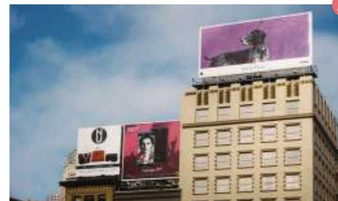
Размещение РЕКЛАМНЫХ КОНСТРУКЦИЙ на кровле запрещено
