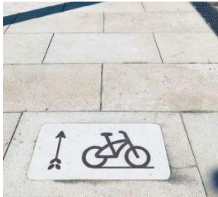
ВСТАВКИ. Включение в состав покрытий элементов (металлических, полимерных и др.) - полос, пластин, решеток - позволяет добавить покрытиям дополнительную фактуру и блеск. Такие вставки могут выполнять функцию навигации или воплощать идентичность места.
