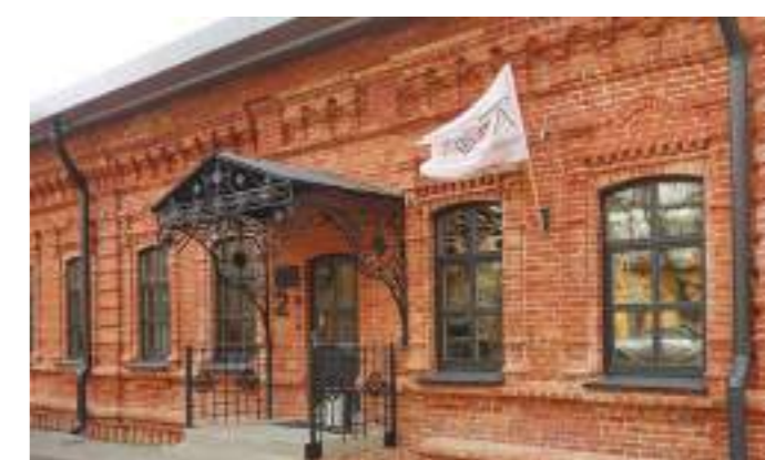
ВОССТАНОВЛЕНА первоначальная форма и расстекловка окон исторического здания
