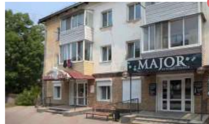
Козырек врезан в часть балкона, элементы фасада не должны ПЕРЕКРЫВАТЬ друг друга
