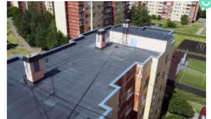
ПЛОСКАЯ КРОВЛЯ выполнена качественно, имеет опрятный внешний вид
