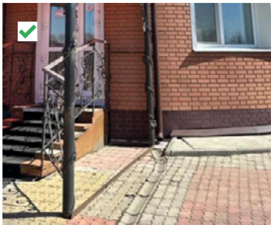
На участке предусмотрены лотки и уклоны в покрытии для отведения воды
